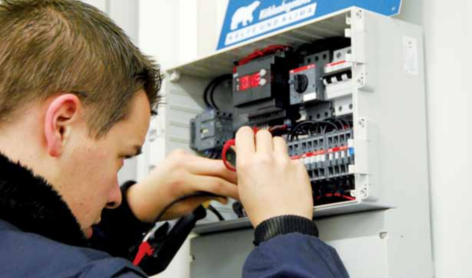
Ein Servicemonteur der Dresdner Kühlanlagenbau im Einsatz: Überprüfung der Steuer- und Regelungstechnik.
