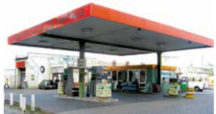
Hier wird investiert: 2014 wird die Tankstelle modernisiert und renoviert.
