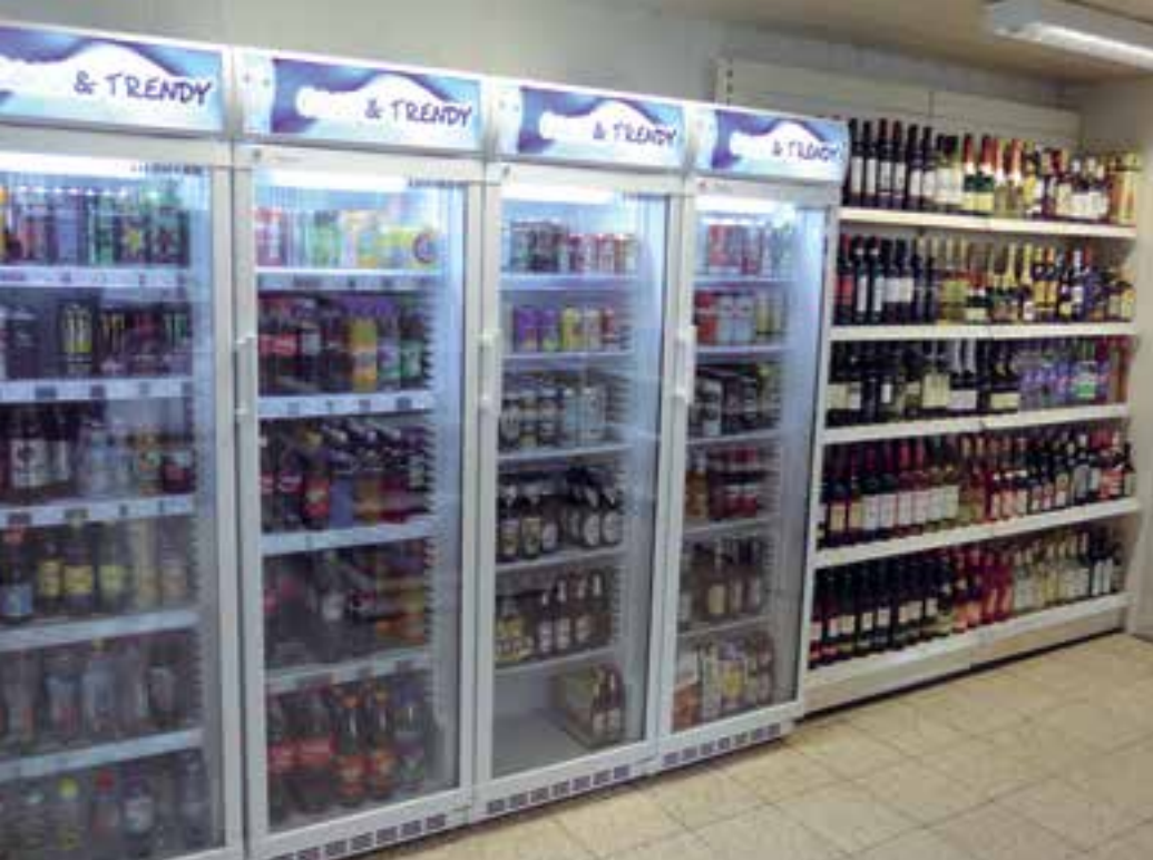
Ansprechend werden die Getränke nach dem Umbau in effizienten Kühlregalen präsentiert.
