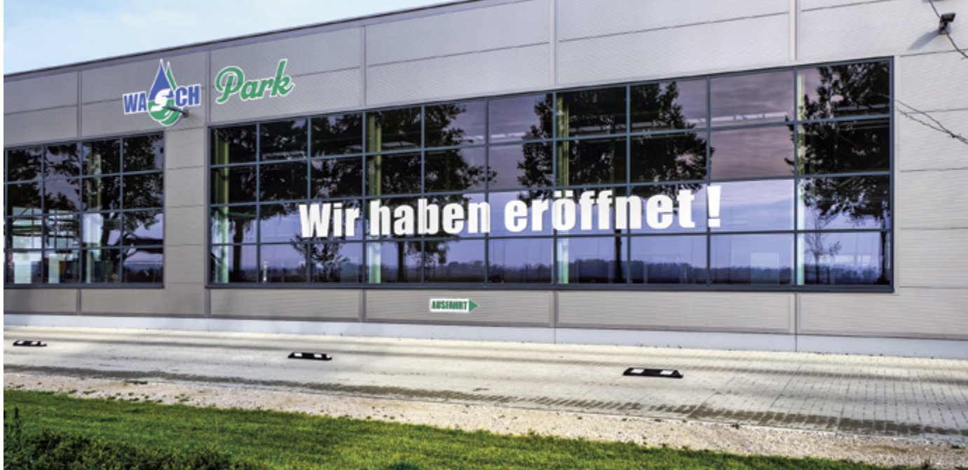
Im Mai des vergangenen Jahres konnte der Waschpark Neutraubling nach zwölfmonatiger Bauzeit eröffnet werden.
