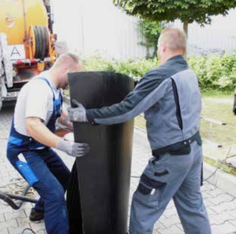
Car-Wash-Center in Walldorf. Vorgefertigte PE-HD-Plattenelemente zum Einbau in schadhafte Schlammfänge und Abscheider ermöglichten im Juni 2015 eine schnelle Montage und Wieder-Inbetriebnahme nach nur 2 Arbeitstagen.
