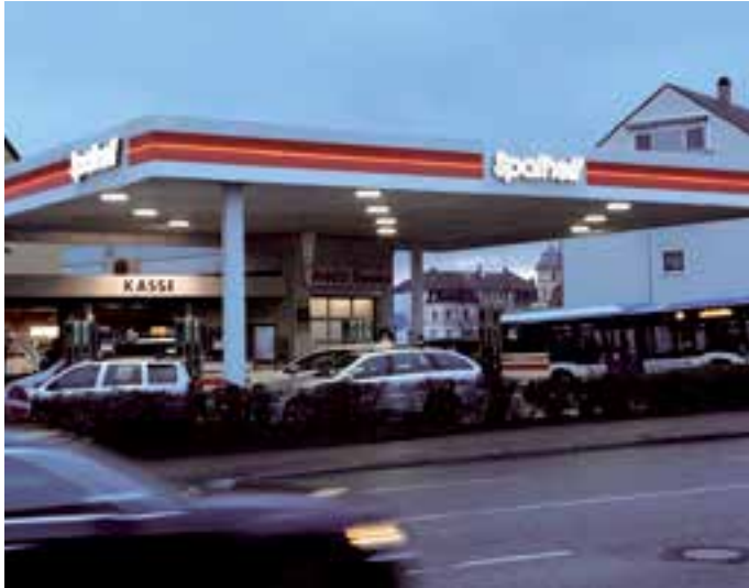
Alpha Signs berät, plant, entwirft und montiert von der Fassadenverkleidung über Tankdachattiken, Lichtwerbeelemente bis zur LED-Beleuchtung.
