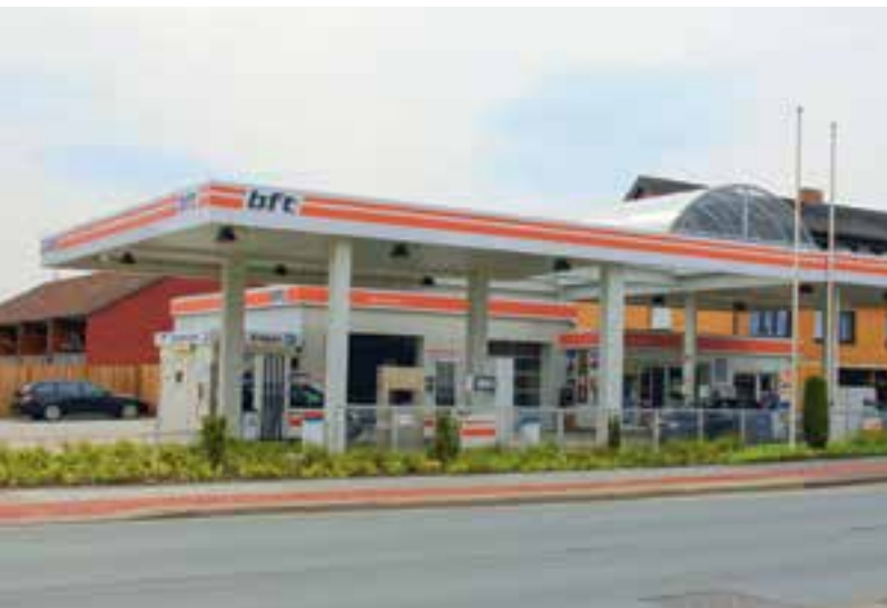
Die bft-Tankstelle von Detlef Vornmoor im niedersächsischen Vechta.
