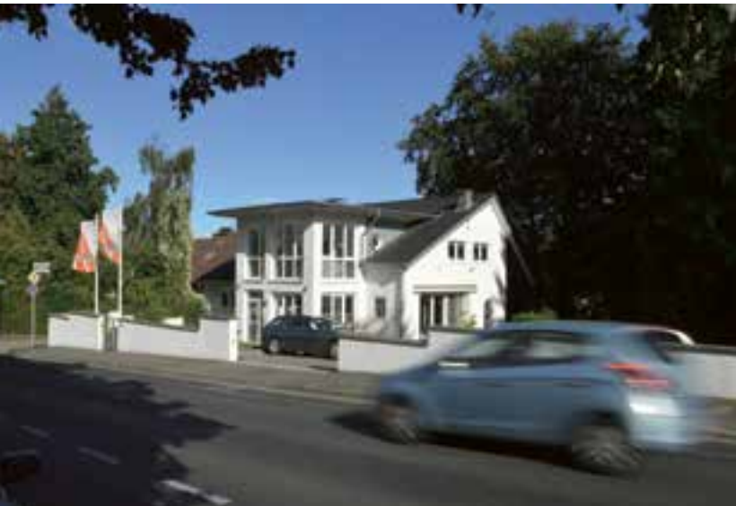
Seite 6 – 7 | eft & bft: Alles unter einem Dach
