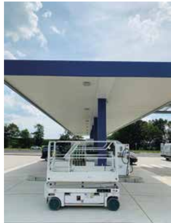
Umbau der Jäger-Station
