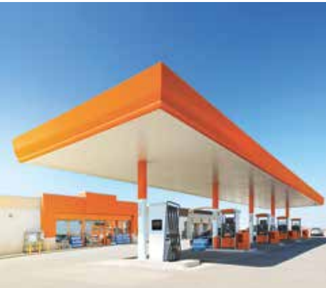
Seite 16 | In nur sieben Schritten von der Tankstelle zum smarten Ladepunkt
