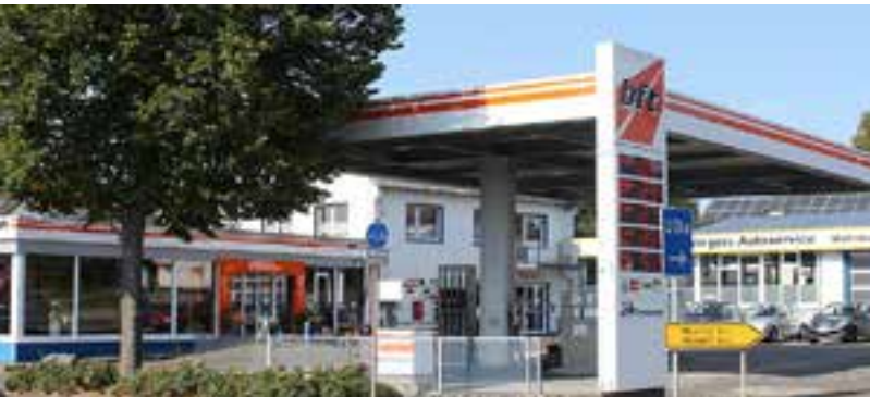
Die Tankstelle Marsberg von außen nach dem Umbau.
