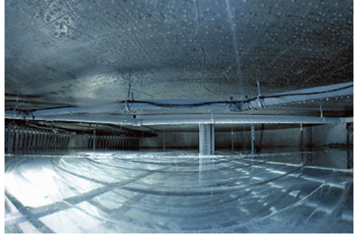
Innenansicht eines Viessmann-Eisspeichers
